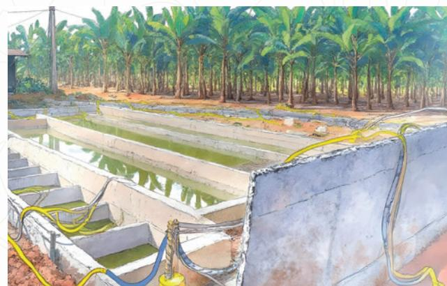
Las plantas de recirculación por lo general constan de un sistema de cribado como pretratamiento, proceso de coagulación – floculación, sedimentación, remoción y disposición final de lodos y almacenamiento del agua tratada, según las recomendaciones de GIZ (2019).
